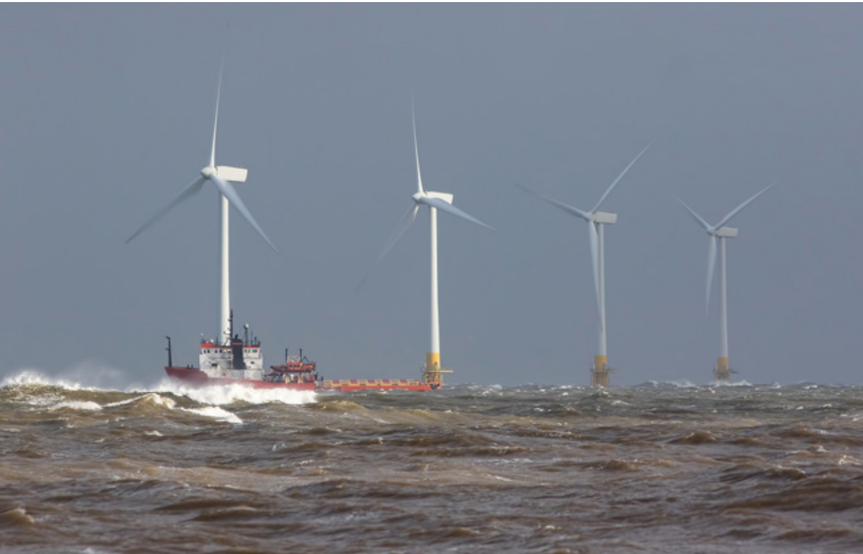
Die Beschichtung von Windkraftanlagen wird regelmäßig geprüft, Ausbesserungen können teuer werden – vor allem auf Offshore-Anlagen.
