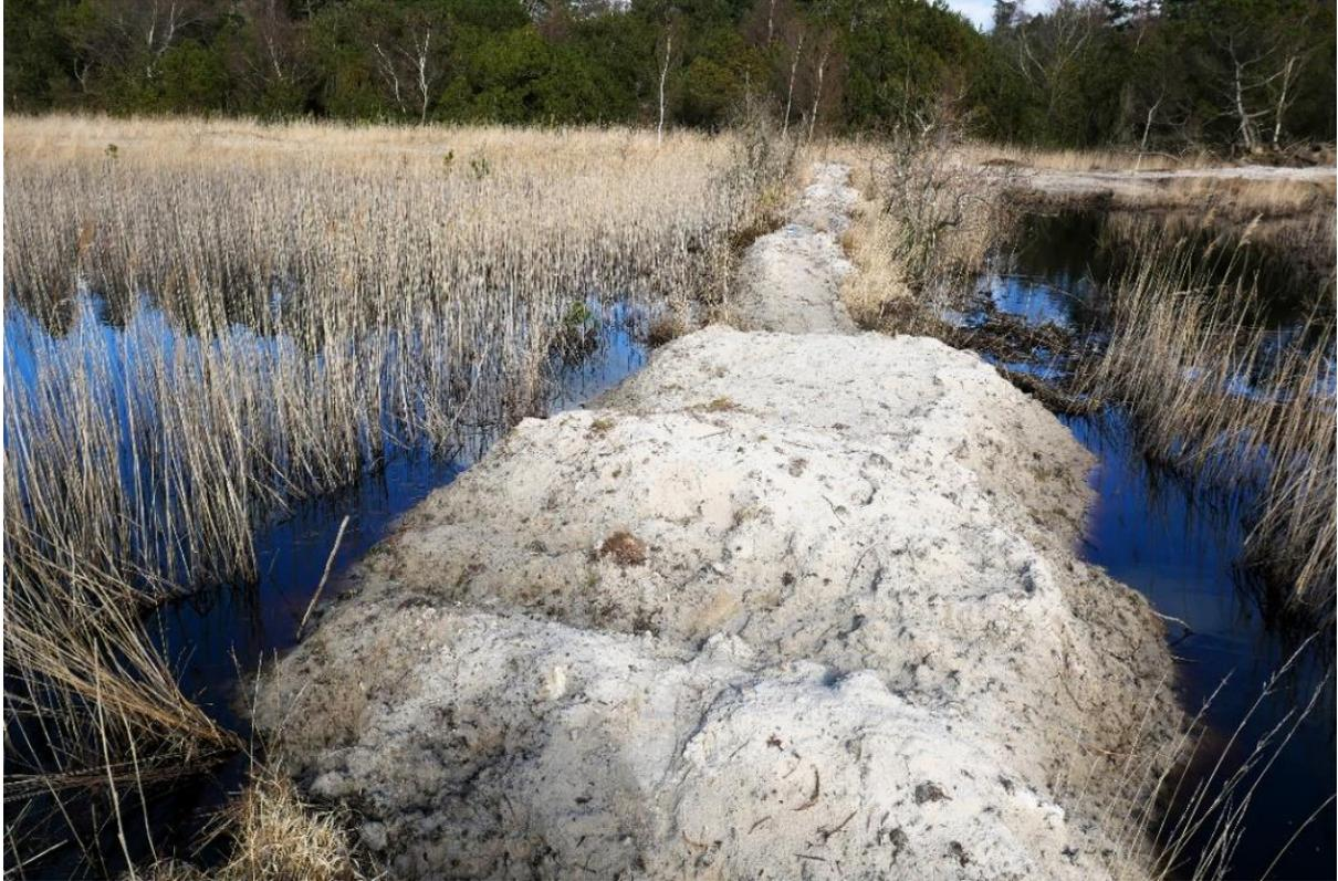
*Abbildung 5: erhöhte Überlaufschwelle in den ehem. Karpfenteichen*
