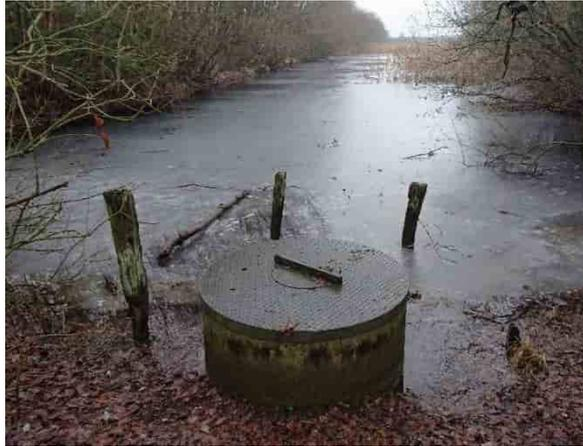
**Abb. 5: Löschwasserentnahmestelle**
