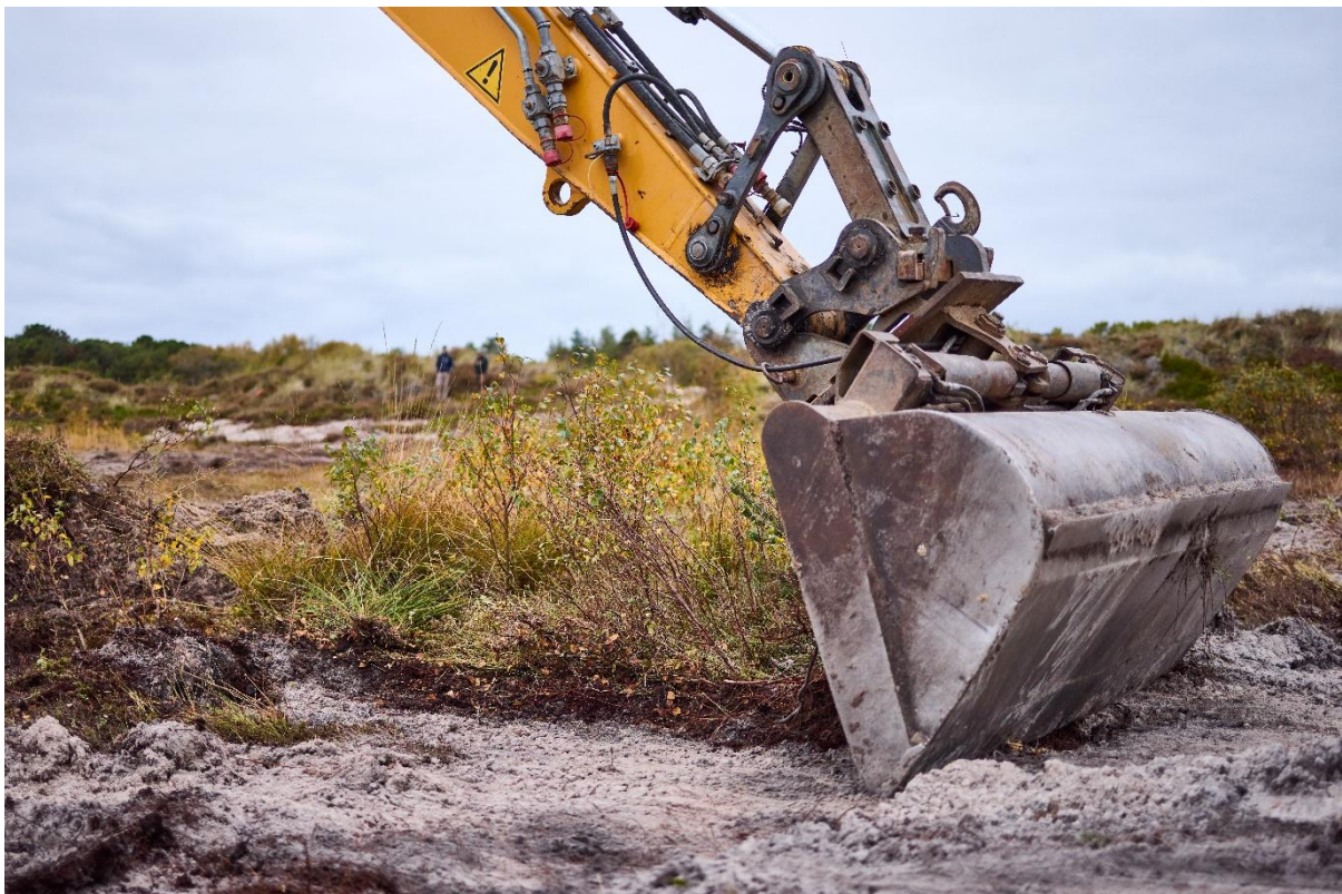
Abbildung 19: Die Vegetationsschicht inkl. oberster Bodenschicht wird möglichst vollständig bis auf den mineralischen Sand entfernt.
