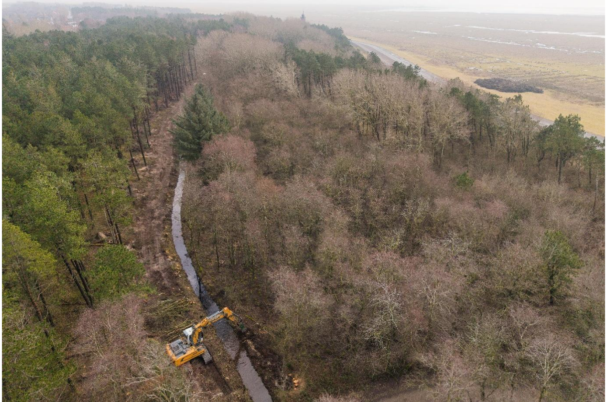
Abbildung 16: Drohnenaufnahme des Baggers des DHSV beim Verschluss eines Gruppen-Abflusses. Der Bagger befindet sich auf der neu angelegten Waldgasse.
