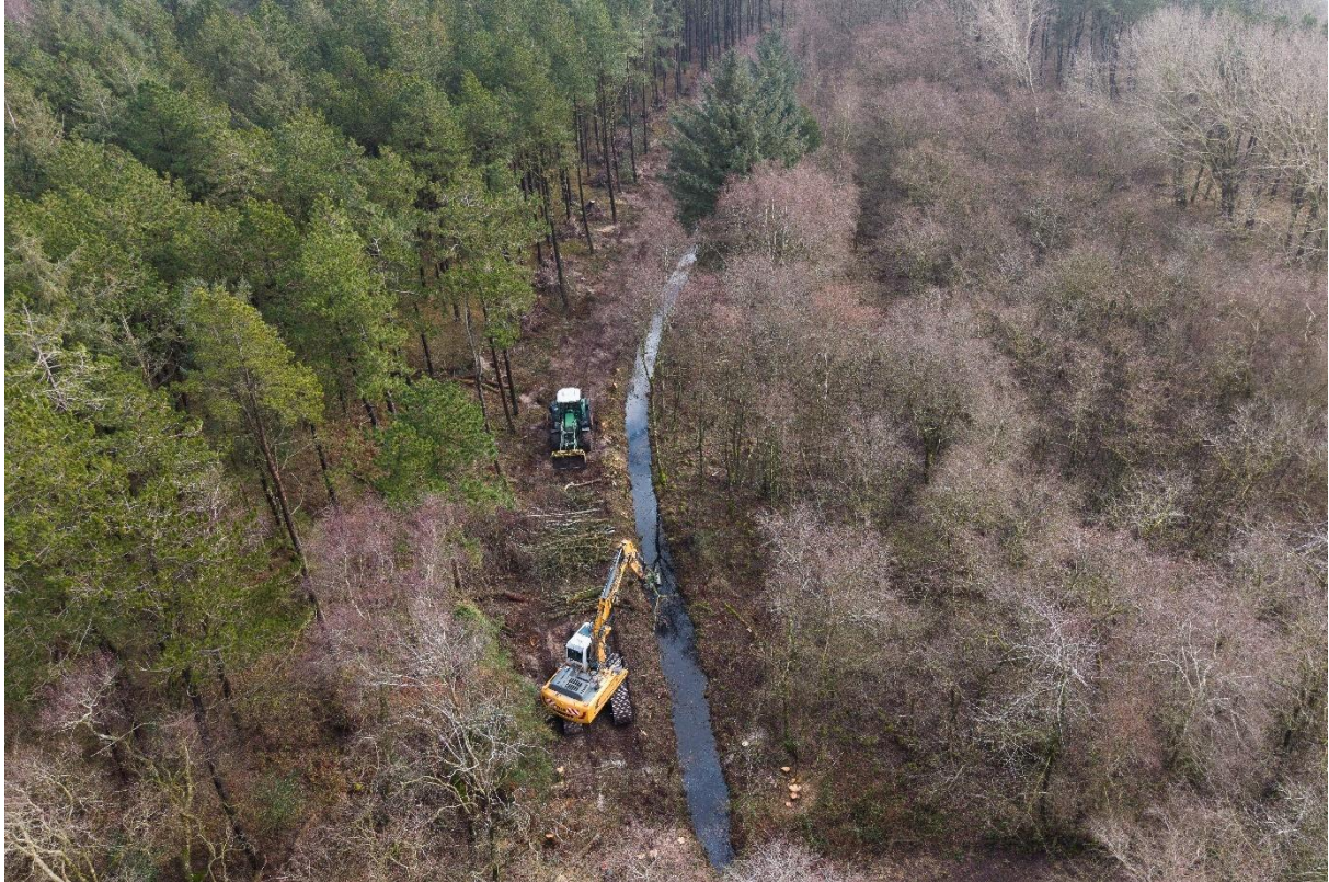
Abbildung 14: Drohnenaufnahme: Bagger und Traktor des DHSV bei den Arbeiten zur Schaffung der Waldgasse im Bereich Böhl.
