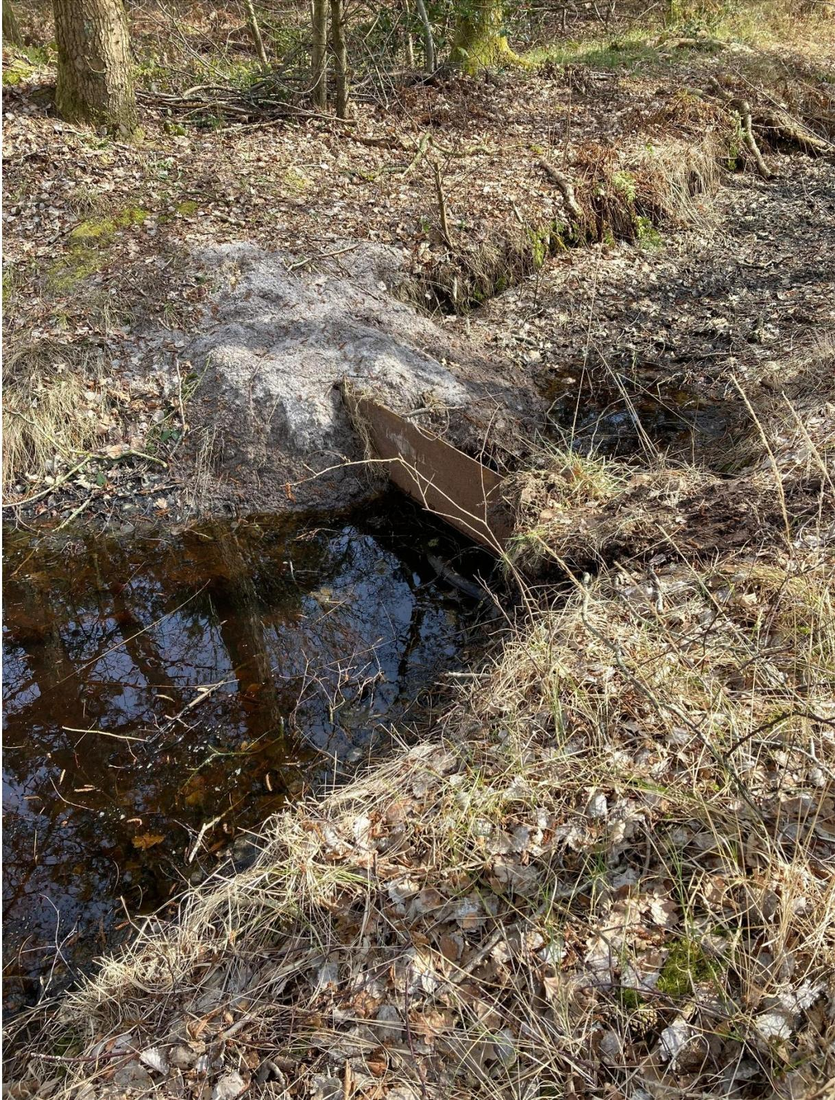
*Abbildung 8: Erstes Staublech im Norden des Dünengebiets zum Anstauen eines Grabens, der in nördlicher Richtung entwässert (Bild aufgenommen am 27.03.2025).*
