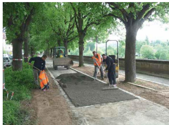
Foto 33: Herstellung einer wassergebundenen Deckschicht mit organischem Bindemittelzusatz (Bildquelle: Eppel 2014)
