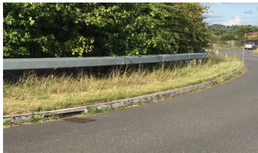
Foto 42: Einbau eines sog. „Wildlife Kerbstone“ am Rand einer stark befahrenen Straße (Bildquelle: Amphibienschutz 2025)
