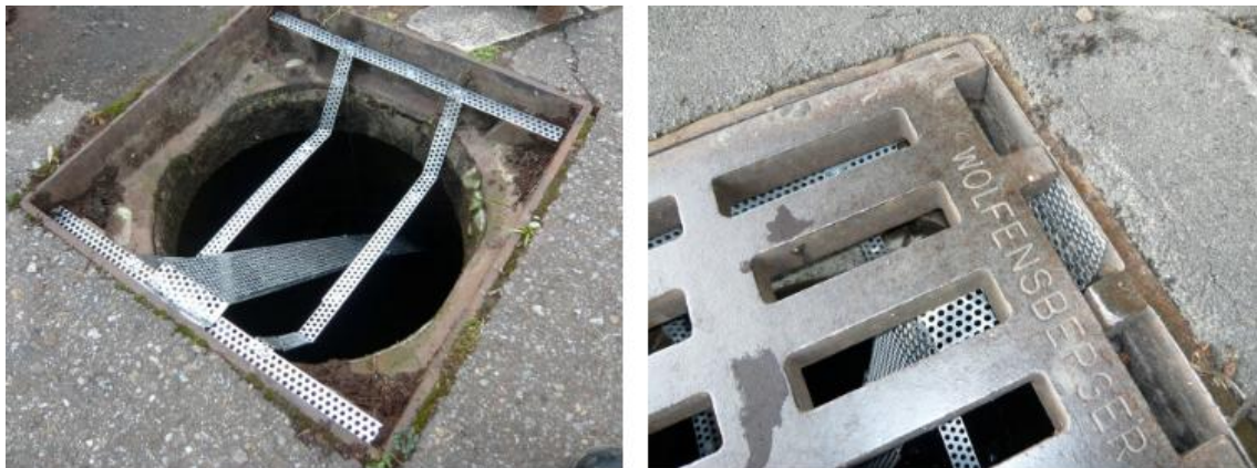
Foto 45: Die Ausstiegsleiter verbindet die Wasser führende Zone und den Schlitz der Schachtabdeckung (Bildquelle: Lippuner 2007)
