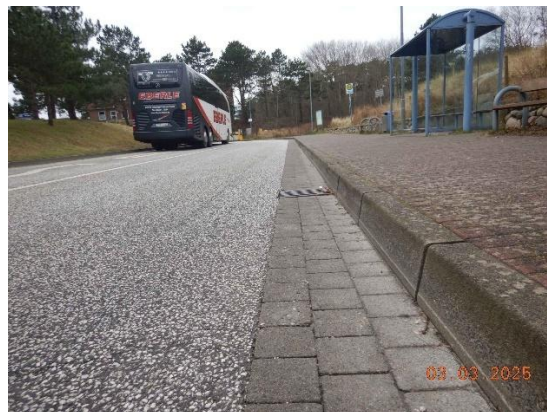
Foto 66: ungesicherte Entwässerungsschächte und Bordsteinkanten im Bereich der Bushaltelinie
