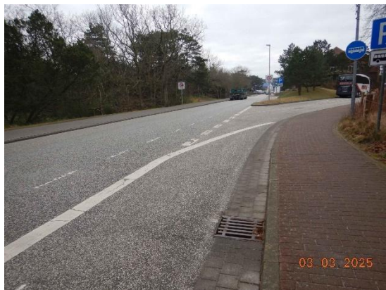
Foto 66: ungesicherte Entwässerungsschächte und Bordsteinkanten im Bereich der Bushaltelinie
