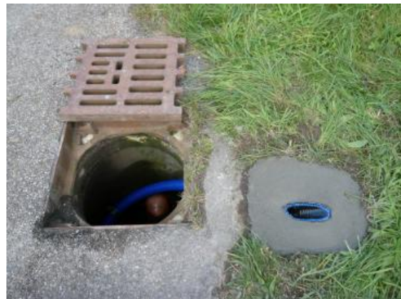
Foto 47: Amphibtec-Ausstiegsröhre, bei der im oberen Teil des Ablaufs von außen in die Wand gebohrt wird (Bildquelle: Lippuner 2007)
