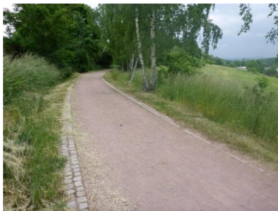
Foto 32: Beispiel eines Radweges in ungebundener Bauweise, seitlich mit Pflaster eingefasst
