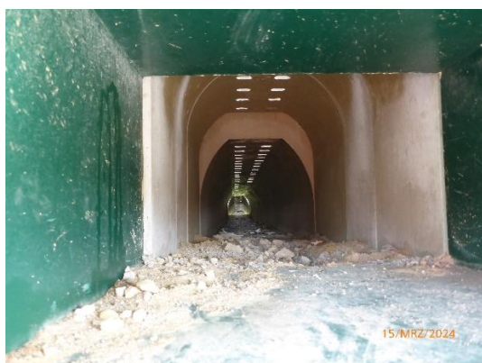
Foto 51: Lichteinfall in einem im Bau befindlichen Klimatunnelsysteme
