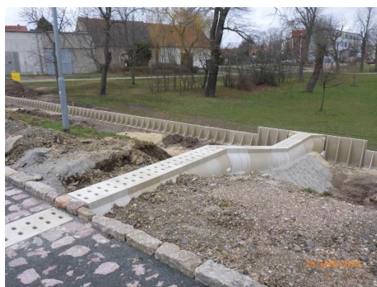
Foto 52: Möglichkeiten des Ausgleichs vom Höhenversatz beim oberflächenbündigen Einbau
