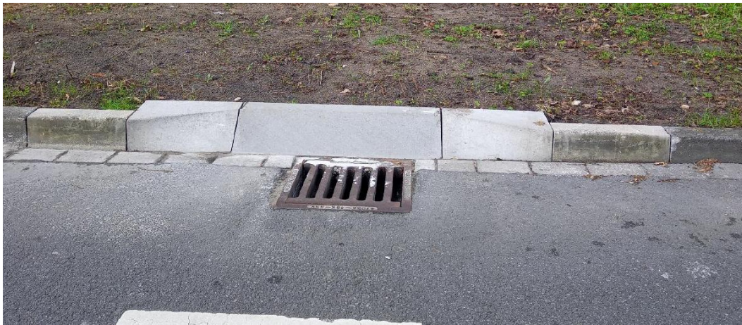
Foto 39: Flachbordstein F15 jedoch mit sehr kurzer Abschrägung (Bildquelle: Drouyn 2021)
